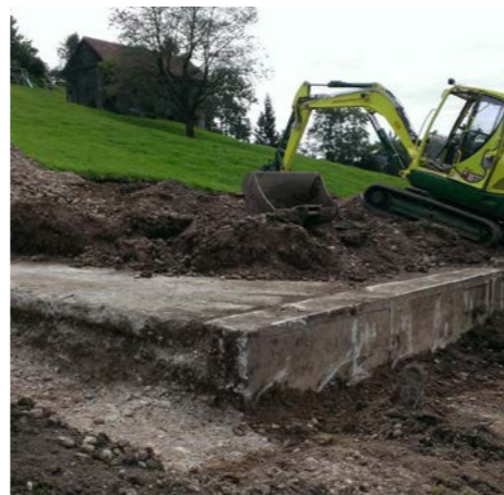
Der Neubau des Reservoirs Oberplatten stärkt die Versorgungssicherheit.
